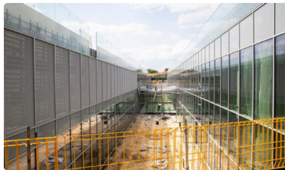
Widok na patio pomiędzy laboratoriami a strefą warsztatową – w trakcie realizacji
