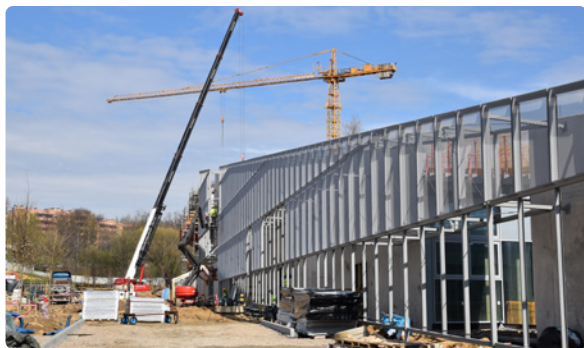
Zachodnia elewacja powstającego budynku – w trakcie realizacji
