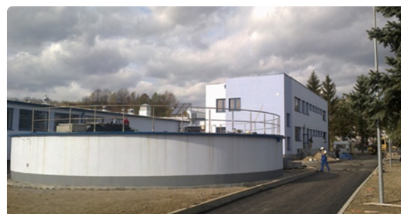
Zbiornik oczyszczalni ścieków w Tuchowie
