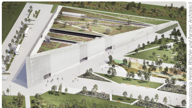
Obiekt z lotu ptaka – widoczny ogród na dachu oraz park z placem zabaw
